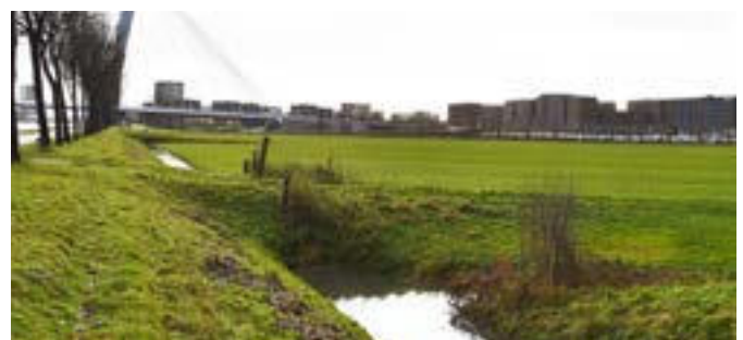
bestaande constructie dijkverbindingen
